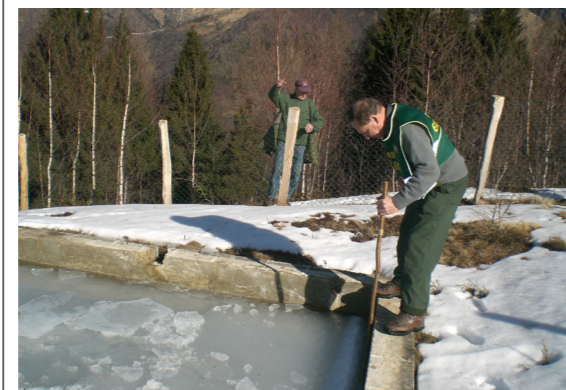
Sopralluogo ad una vasca di raccolta acqua a Logone.
